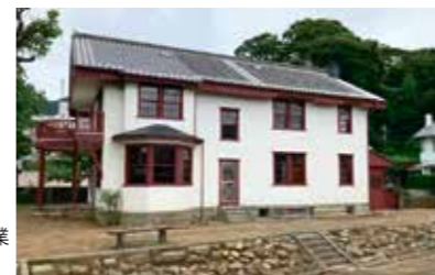
和歌山県の「旧西村家住宅」(重要文化財保存修理工事)
