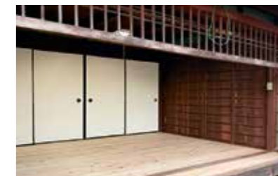
古民家の改修 (H様邸床板張り替え工事)
