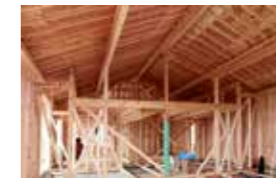
施工現場の様子
